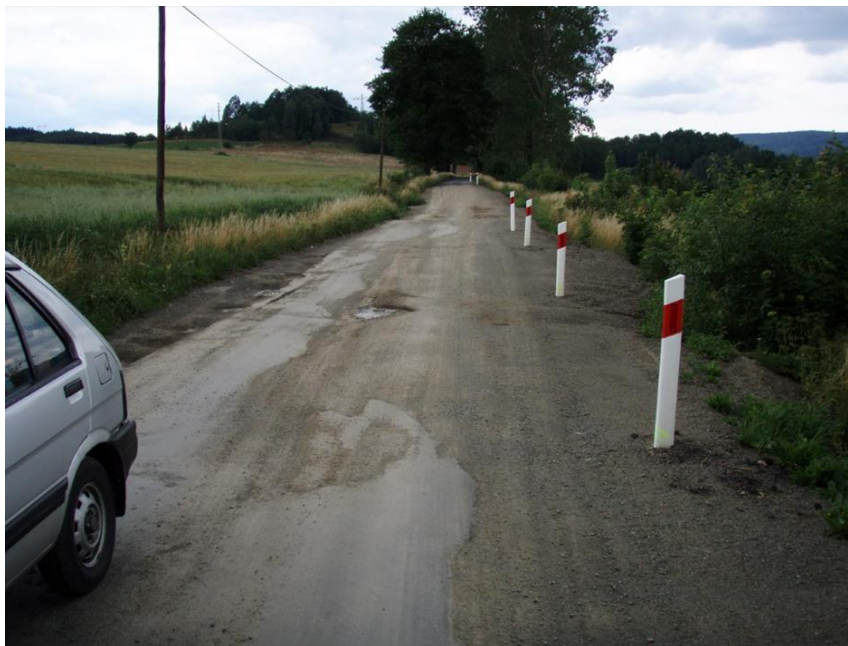
Ryc. 24 Niszczony przez dziesięciolecia fragment drogi Ciechanowice – Miedzianka wskutek zsuwania przypowierzchniowej partii gruntu (fot. M. Kasprzak, 2007).
