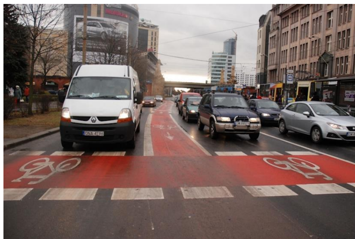
Ryc. 32 Pas rowerowy zakończony słuzą rowerową. Źródło: Pasy, kontrapasy oraz słuzы rowerowe we Wrocławiu - wRower.pl - Rowery od A do Z
