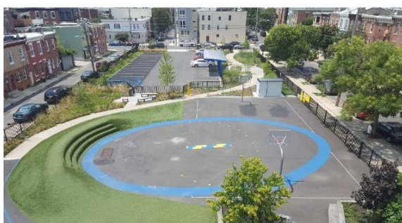
Ryc. 10 Przykłady zagospodarowania boisk służących jako suche zbiorniki podczas intensywnych opadów deszczu, źródła (od lewej): https://www.padeasla.org/wp-content/uploads/2018/10/CHESTER-ARTHUR_PROJ-DOCS_2018_0531_FINAL.pdf ; https://www.publicspace.org/works/-/project/h034-water-square-in-bentemplein
