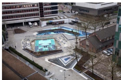
Ryc. 10 Przykłady zagospodarowania boisk służących jako suche zbiorniki podczas intensywnych opadów deszczu, źródła (od lewej): https://www.padeasla.org/wp-content/uploads/2018/10/CHESTER-ARTHUR_PROJ-DOCS_2018_0531_FINAL.pdf ; https://www.publicspace.org/works/-/project/h034-water-square-in-bentemplein
